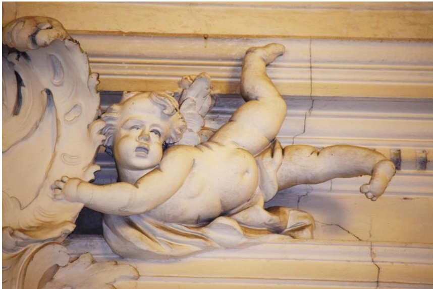
Fig. F.47 Chiesa del Carmine, Noto. Detail. (left)
