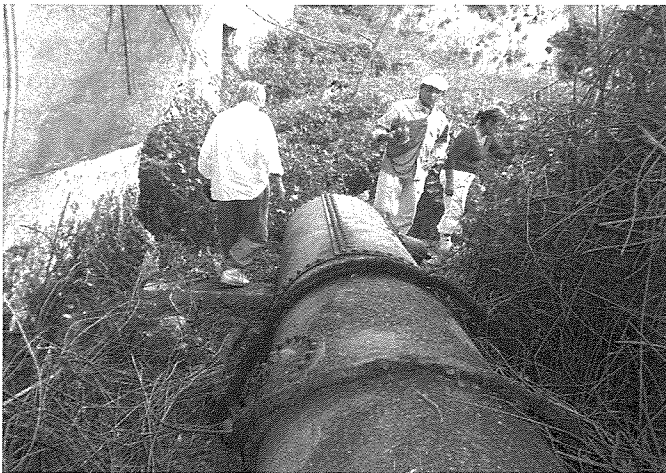
4: Wieħed mit-tankijiet (jew drum) tal-isteam boiler kif jinsab preżentament fil-parapett tal-istazzjon
