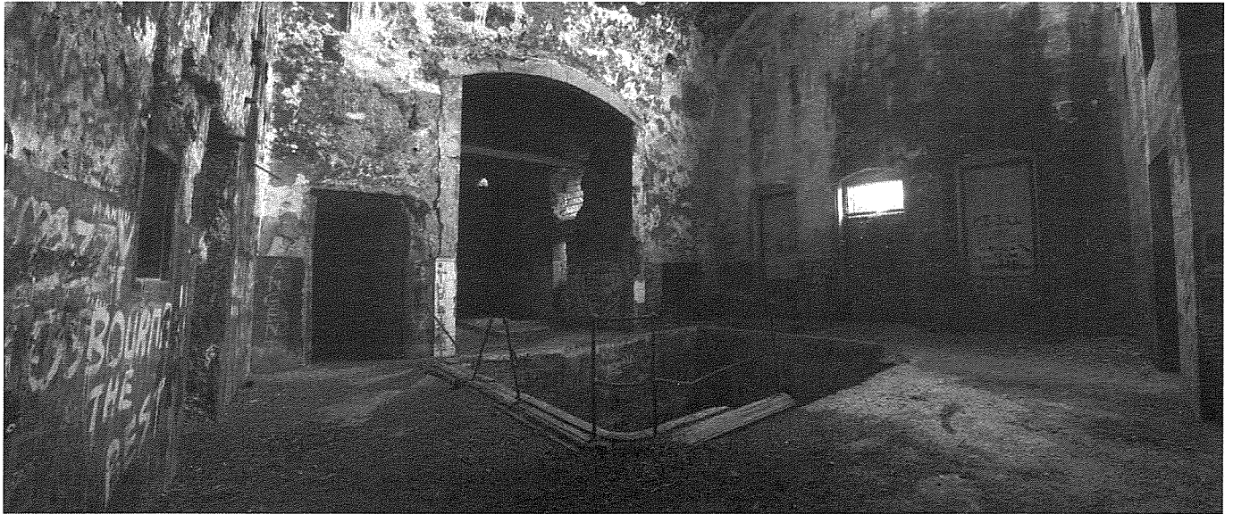
6: L-ispażju ċentrali tal-istazzjon - fin-nofs 'engine shaft' 16 il-metru fond - lemin bieb u żewġ twieqi fil-faċċata tal-wied - xellug żewġ fethiet; iż-żgħir tal-"coal bunker" waqt li l-kbir huwa mic-"chambers" fejn kien jitpoġġa wiehed mill-boilers
