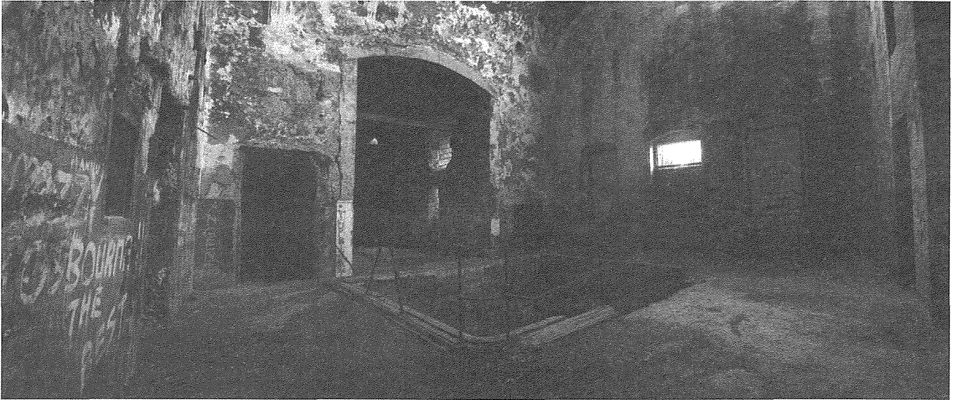
6: IL-ispazzju ċentrali tal-Is-tazzjon - fin-nofs 'engine shaft' 16 il-metru fond - lemin bieb u żewġ twieqi fil-faccata tal-wied - xellug żewġ fethiet; iż-żgħir tal-'coal bunker' waqt li l-kbir huwa mic-'chambers' fejn kien jitpogga wieħed mill-boilers
