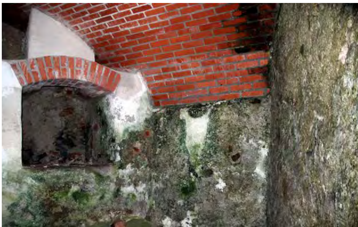
Abb. 07 & 08: Ruinen der Sperranlagen am Paß Strub; Küche in den ehemaligen Kasematten. Photos mit freundlicher Genehmigung: Gottfried Maierhofer, Zell am See
