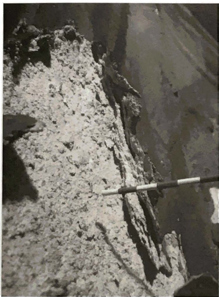
Fig. 2 Dettaglio di uno dei conci di pietra che mostra grave decoesione ed esfoliazione [foto: R. De Angelis].
