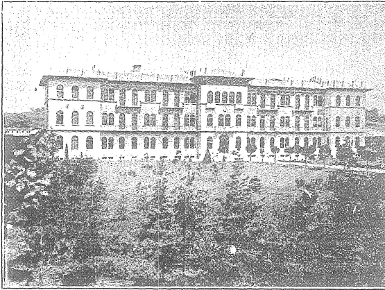
Facciata ta li Scola.
