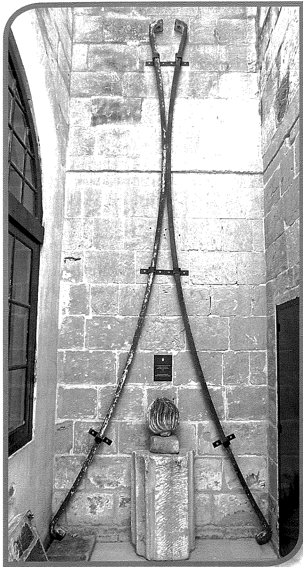
Tnejn minn tminn partijiet ta' ċirku tal-ħadid li bih ġiet imdawra l-koppla, li ġie ordnat u impurtat minn barra minn Malta. Dawn għadhom jeżistu sal-lum u tnejn minnhom jinsabu esebiti fil-Mużew Wignacourt. (Ritratt: J G Scerri)
