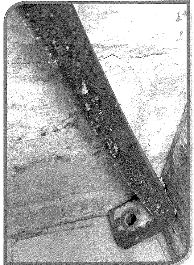
Tnejn minn tminn partijiet ta' ċirku tal-ħadid li bih ġiet imdawra l-koppla, li ġie ordnat u impurtat minn barra minn Malta. Dawn għadhom jeżistu sal-lum u tnejn minnhom jinsabu esebiti fil-Mużew Wignacourt. (Ritratt: J G Scerri)
