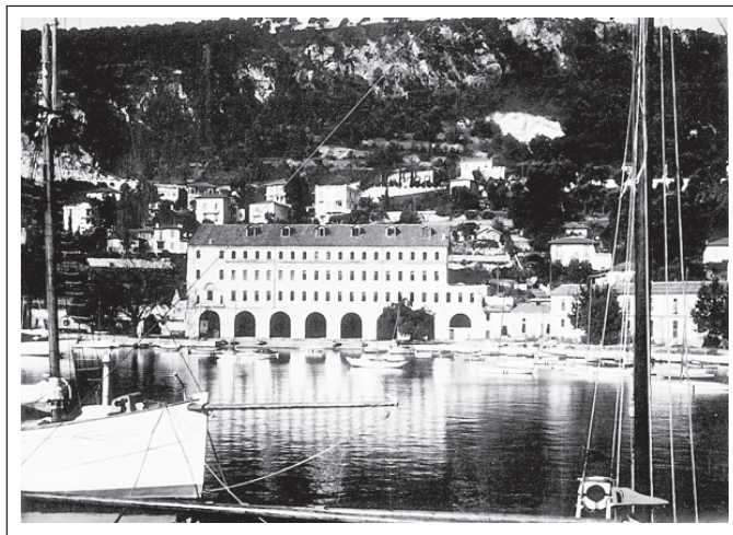
Caserne militaire, photo incluse dans le projet de démolition, septembre 1941 (© ADAM).
