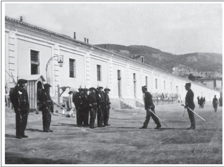
Bataillon de chasseurs alpins devant la corderie dans son état d'origine.
