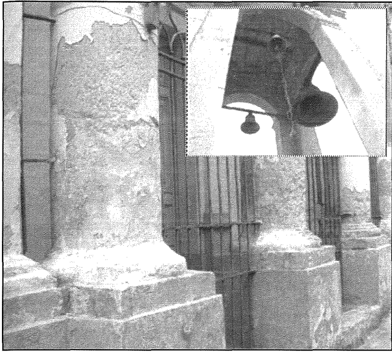
Kappella tad-Duluri: il-Knisja bis-siment trid titneħha għaliex din hija wahda mill-kawzi ta' hsara fil-parti ta' isfel tal-hitan, kolonni u bażijiet u fil-kampnari (insert)
