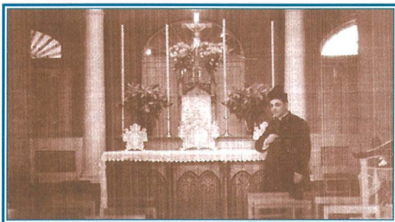
Kappella proviżorja ġewwa l-villa tas-Sur Alfonso Maria Galea – intużat sakemm saru l-ewwel tiswijiet wara t-tiġrif tal-gwerra. Il-Kappillan Dun Ġużepp Inguanez jidher fuq il-lemin tar-ritratt.
