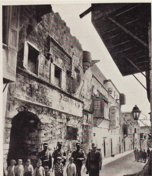
FIG. 115 — RODI - LA VIA DEI CAVALIERI PRIMA DEI RESTAURI.
