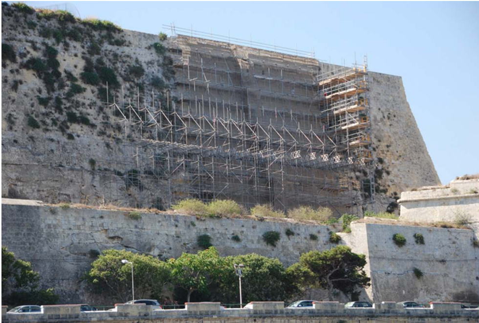
Restauration du demi-bastion de Saint-Michel, fortifications de La Valette, chantier, juillet 2010.
