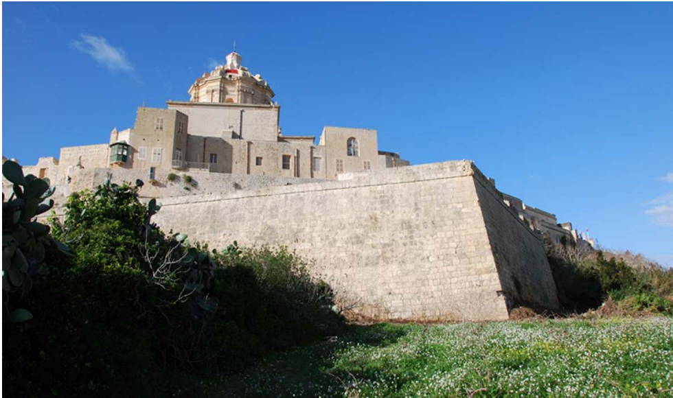
Bastion Despuig, Mdina, avant restauration.
